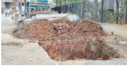
గాంధీ మండపం నిర్మాణం పనులకు శ్రీకారం
